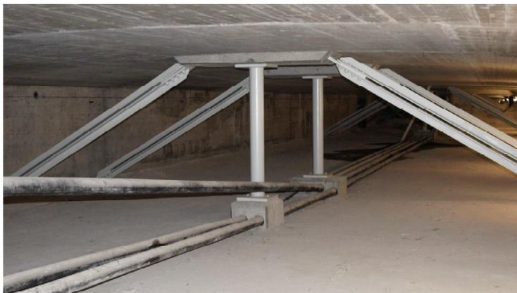
Figura 3.4: Cabos de pré-esforço exterior e tirantes metálicos no interior do tabuleiro
