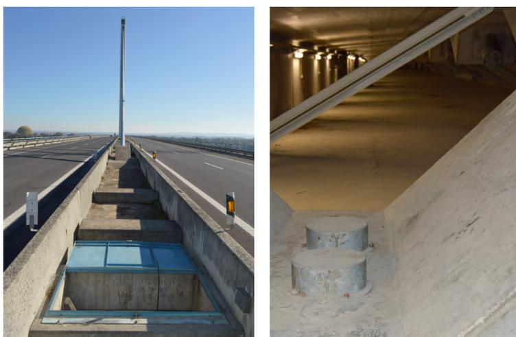
Figura 3.11: Acesso vertical e iluminação interior do tabuleiro da ponte
