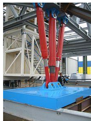
FIGURA 3-1 - “NEUMAYER STATION III” E O CONJUNTO DE HIDRÁULICOS QUE CONSTITUI UM DOS APOIOS DA ESTRUTURA
