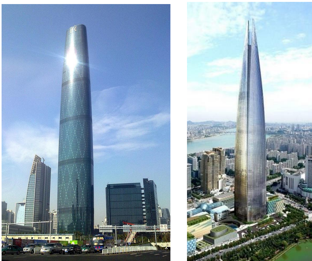
FIGURA 7-3 - EXEMPLOS DE EDIFÍCIOS BASEADOS EM SISTEMAS ESTRUTURAIS DIAGRID (GUANGZHOU INTERNATIONAL FINANCIAL CENTER, À ESQ. E LOTTE SUPER TOWER, À DIR.)
