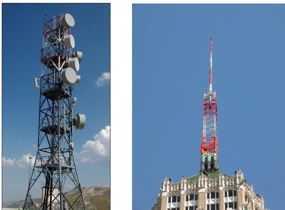
FIGURA 7-2 - EXEMPLOS DE TORRES DE TELECOMUNICAÇÕES HABITUAIS
