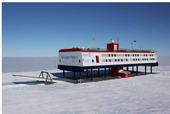
FIGURA 3-1 - “NEUMAYER STATION III” E O CONJUNTO DE HIDRÁULICOS QUE CONSTITUI UM DOS APOIOS DA ESTRUTURA
