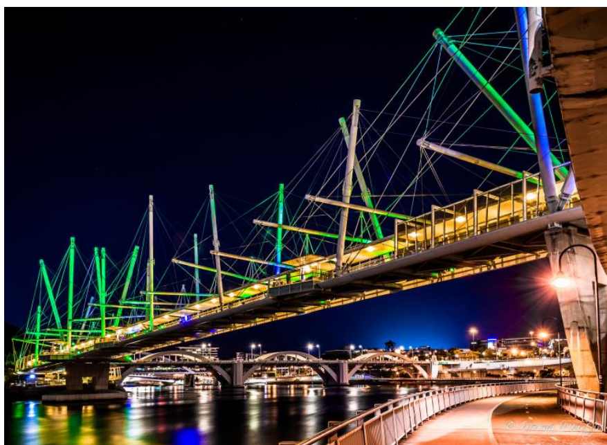
FIGURA 2-18 - "KURILPA BRIDGE", EM BRISBANE, NA AUSTRÁLIA.
