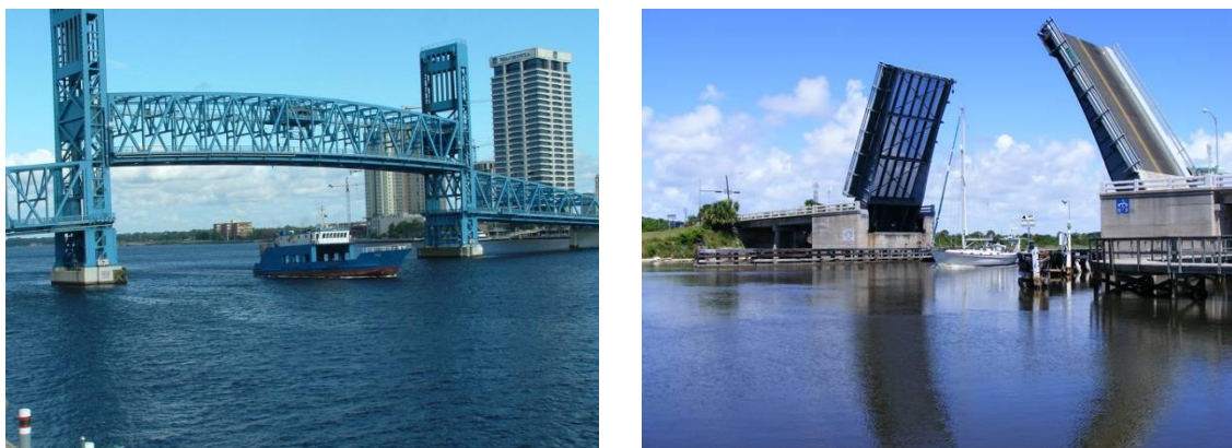
FIGURA 3-3 - EXEMPLOS DE PONTES LEVADIÇAS. PONTE DE JACKSONVILLE (À ESQ.) E PONTE DE PALM COAST (À DIR.) AMBAS EM FLORIDA, NOS EUA.
