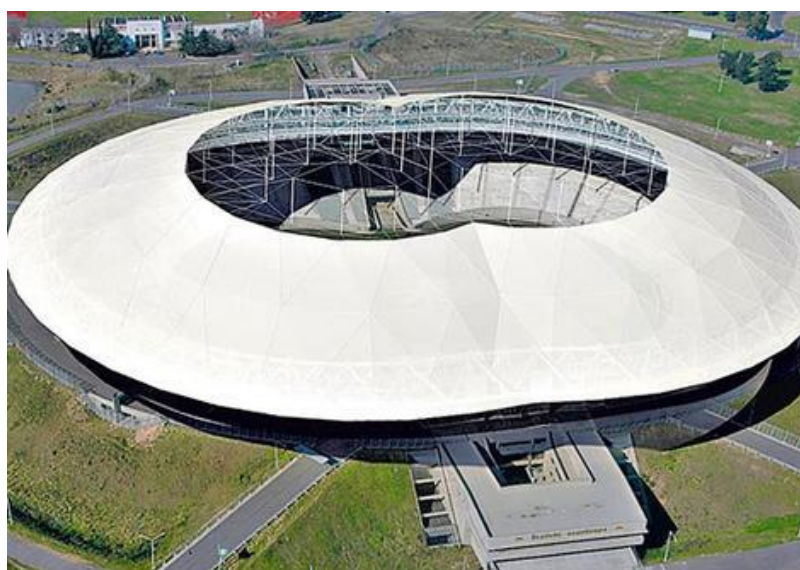
FIGURA 2-10 - COBERTURA DO ESTÁDIO DE LA PLATA, EM BUENOS AIRES NA ARGENTINA
